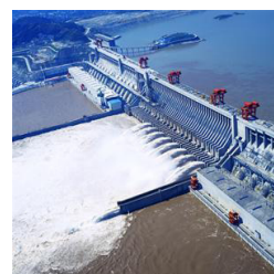
La «diga delle tre gole» sul Fiume Azzurro
